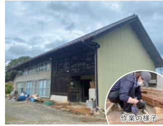
▲改修予定の古民家
