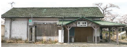
◀解体前の旧夜ノ森駅舎(富岡町提供)
