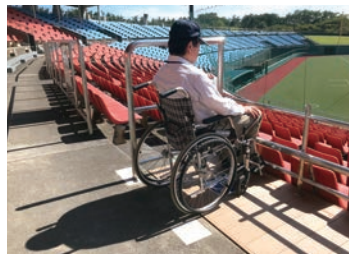
▲車椅子昇降台が設置されバリアフリー化。車椅子用観客席も1箇所(4席)から5箇所(20席)へ増設
