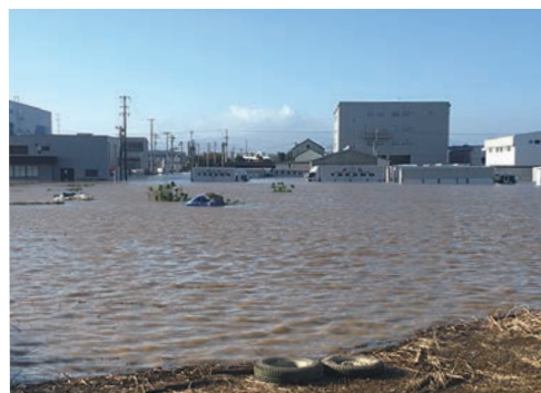
冠水した郡山本社が建つ中央工業団地（10月13日15時撮影）
